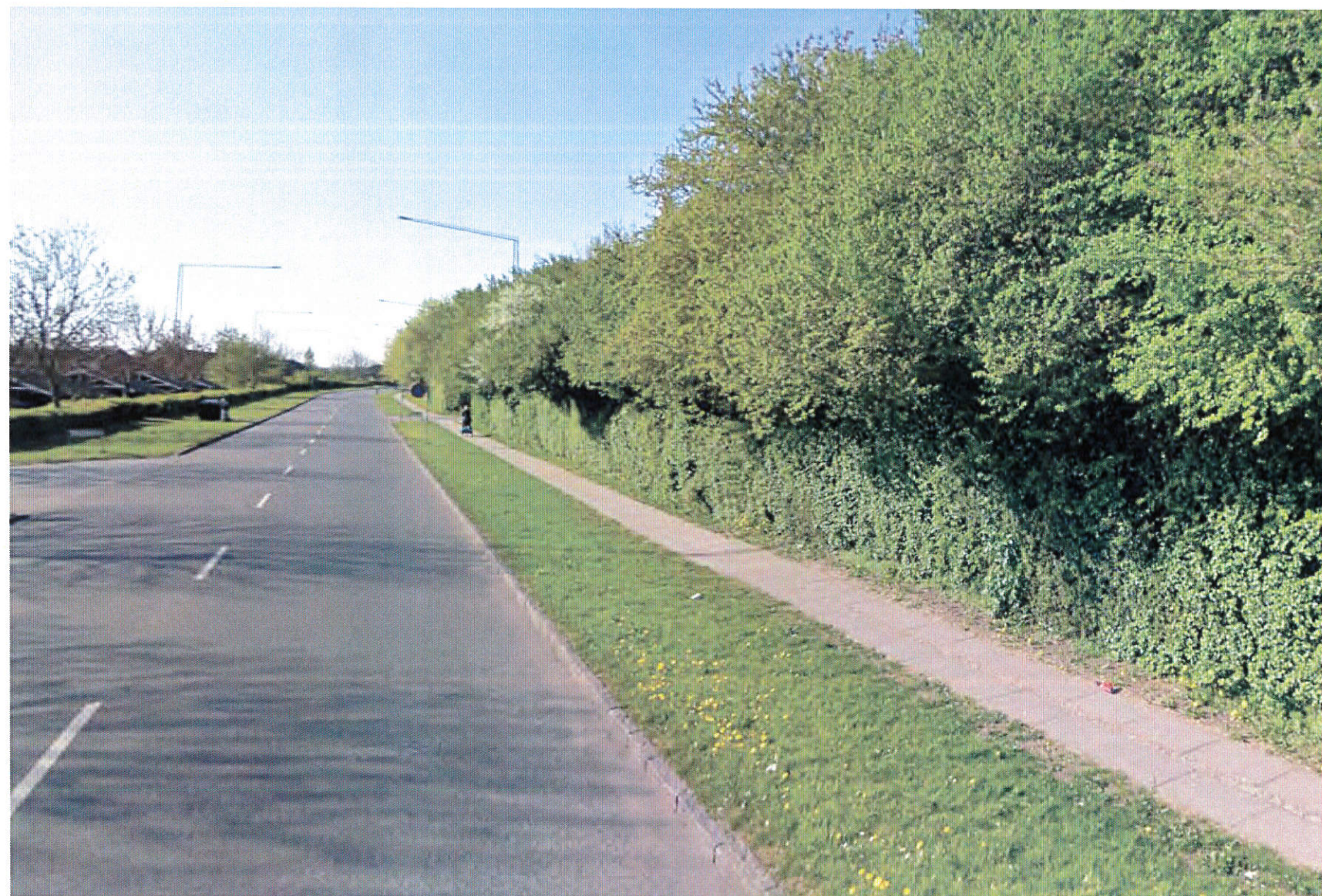
Randplantning langs Stenagervej
