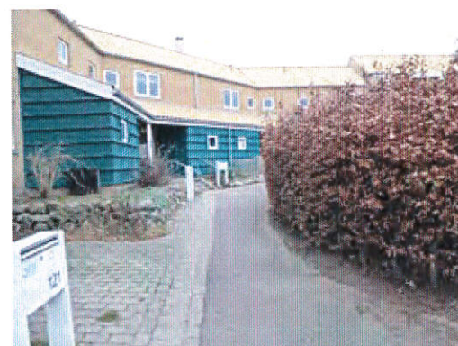
Manglende oversigt fra stien pga. for høj hæk
