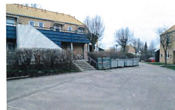
Skæmmende affaldscontainere på torvet
