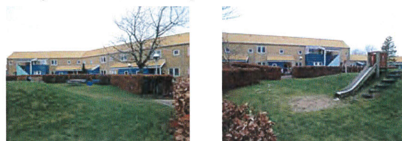
Legepladsen mellem blok 5 og 6
