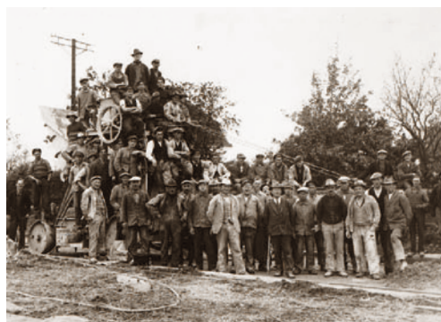
SJAKKET OG DEN STORE 'BETONLÆGGER' FOREVIGET I EN PAUSE UNDER CEMENTBETONPÅLÆGNINGEN PÅ GRENÅVEJ I 1934. HENNING HJORTSHØJ JACOBSENS FAR OG FARBROR VAR EN DEL AF SJAKKET. FADEREN ER IKKE MED PÅ BILLEDET; MEN TIL HØJRE FOR SVINGHJULET SES FARBRØDEREN MED ARMENE OVER KORS. ÅKB, LOKALHISTORISK SAMLING. FOTOGRAF: UKENDT.
