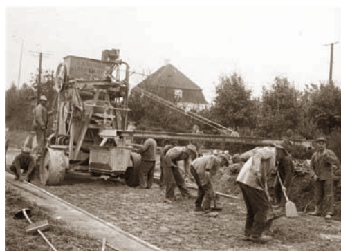
BETONLÆGNING PÅ GRENÅVEJ 1934. ÅKB, LOKALHISTORISK SAMLING. FOTOGRAF: ÅGE FREDSLUND ANDERSEN
